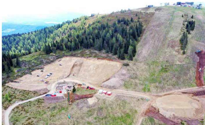
Der Baustellenbetrieb ist derzeit voll im Gange. Neben der Errichtung des Beschneigungsteiches wird im Bereich der Mittelstation Klösterle der Schiweg verbreitert. Im Zuge dieser Baumaßnahmen werden enorme Mengen Erdmaterial ausgehoben und verfrachtet. Schweres Arbeitsgerät ist im Einsatz. Es ist verständlich, dass eine solche Baustelle auch das Inte-
